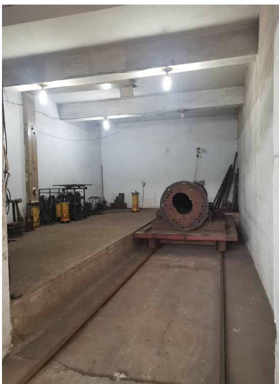
照片 16 探伤室内部
